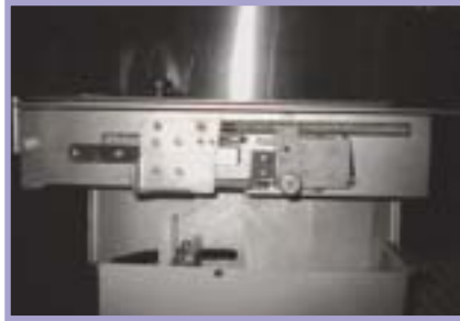
Vista total del evacuador donde se pueden ver las paredes móviles.
